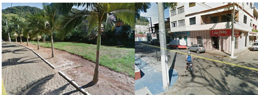
Figura 54 – Aspectos da microdrenagem implantada no município
