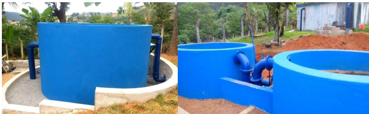
Figura 29 – Registro das instalações de tratamento de água ETA Sede – Detalhe novo filtro
