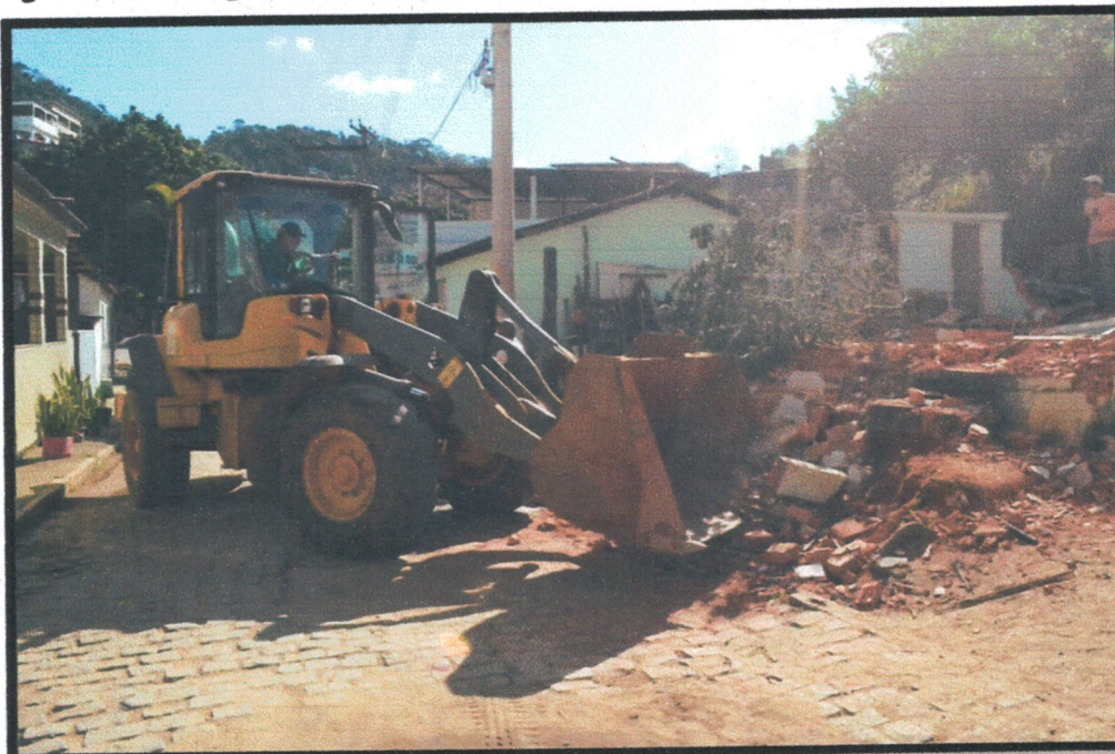
Fig. 02. Pó-carregadeira da prefeitura, retirando os resíduos da demolição.
