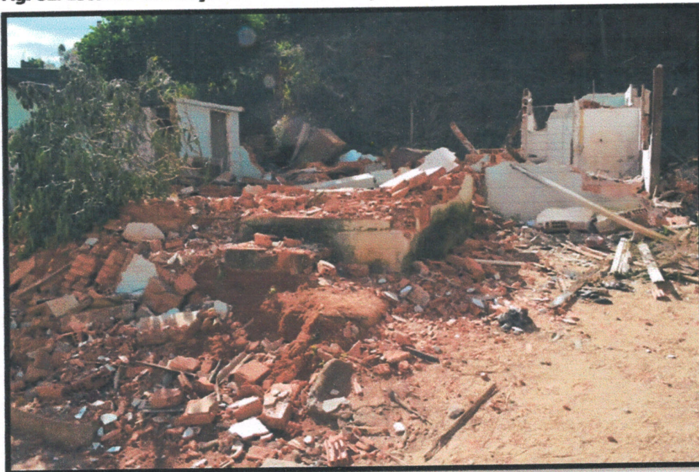
Fig. 01. Local da demolição da residência objeto.
