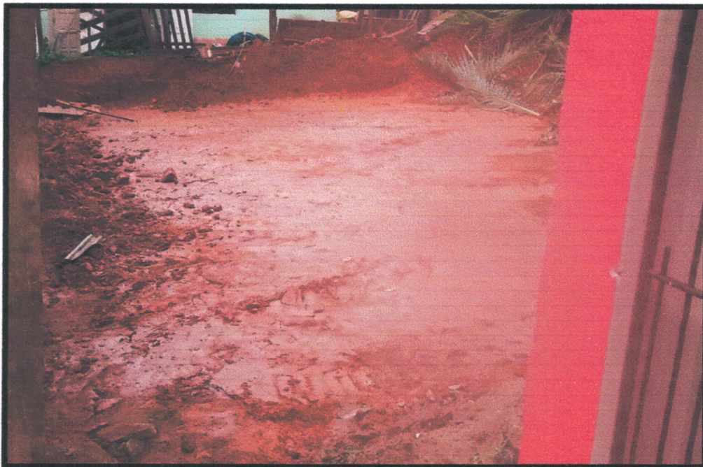
Fig. 03. Imagem do terreno, após a retirada do entulho. Todo material retirado fora transportado e depositado em local licenciado pelo IEMA, na Fazenda Municipal.
