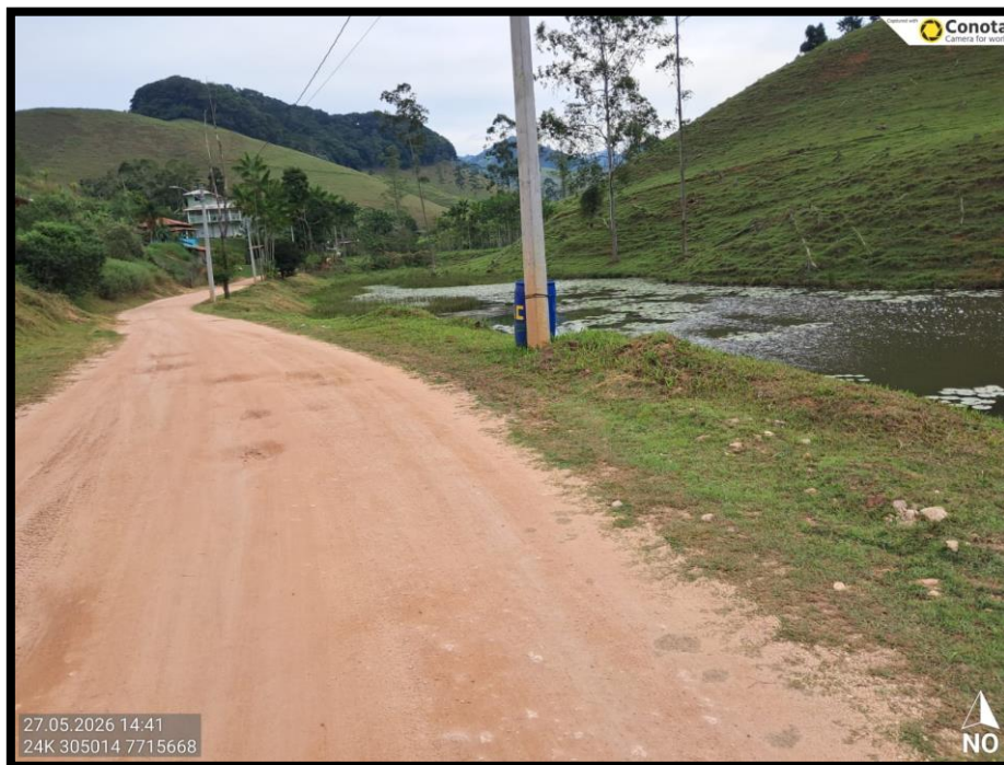
Fig. 03. Melhoria do trecho a ser executado na primeira quinzena de junho/2026.
