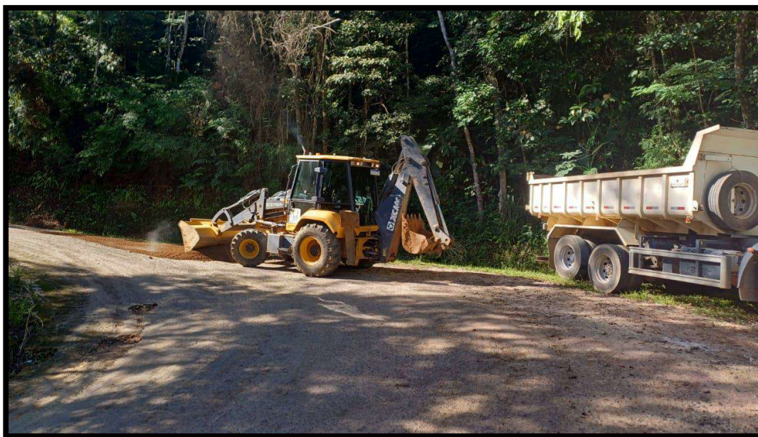
Fig. 05. Maquinário da municipalidade executando reparos no trecho de Quinto Território.
