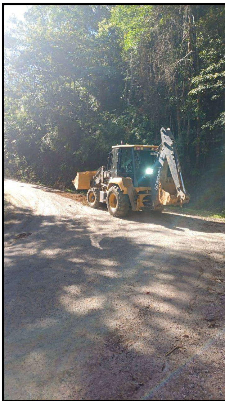
Fig. 01. Retroescavadeira auxiliando no que compete na manutenção da estrada rural.
