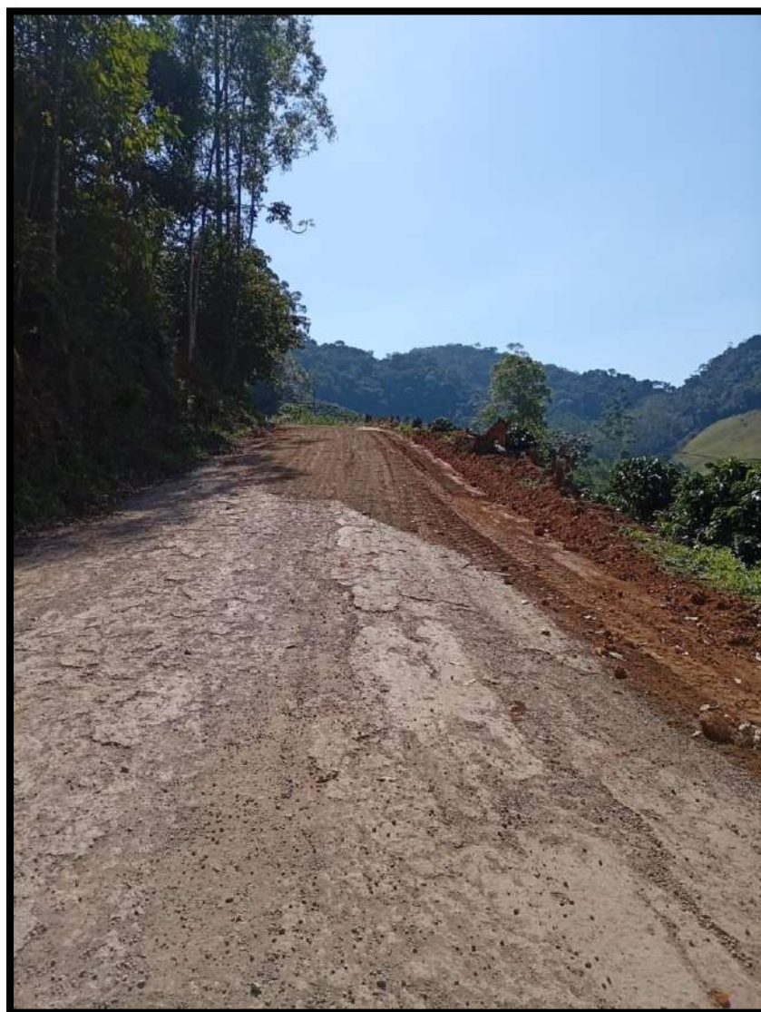
Fig. 04. Trecho de melhoramento recebendo reparos. Todo o processo utiliza motoniveladora, caminhão pipas, caminhões caçamba e rolo compactador.
