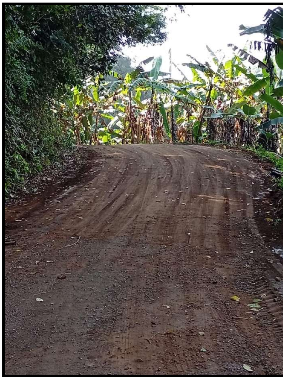
Fig. 02. Aplicação da mistura “revsol + saibro”, atuando como material de revestimento na superfície da estrada municipal.
