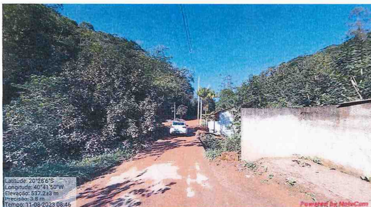
Foto2: No final da tangente, temos uma ponte estreita que necessita sinalização.
