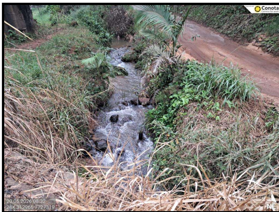
Fig. 05. Córrego que tangencia a estrada objeto. O tráfego de caminhões pesados gera recalque do solo (umidade).
