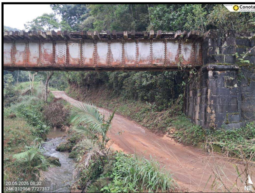
Fig. 02. Comparativo da altura da escavadeira giratória, apresentando 5,00 metros. Já a altura da linha férrea 4,30 metros.
