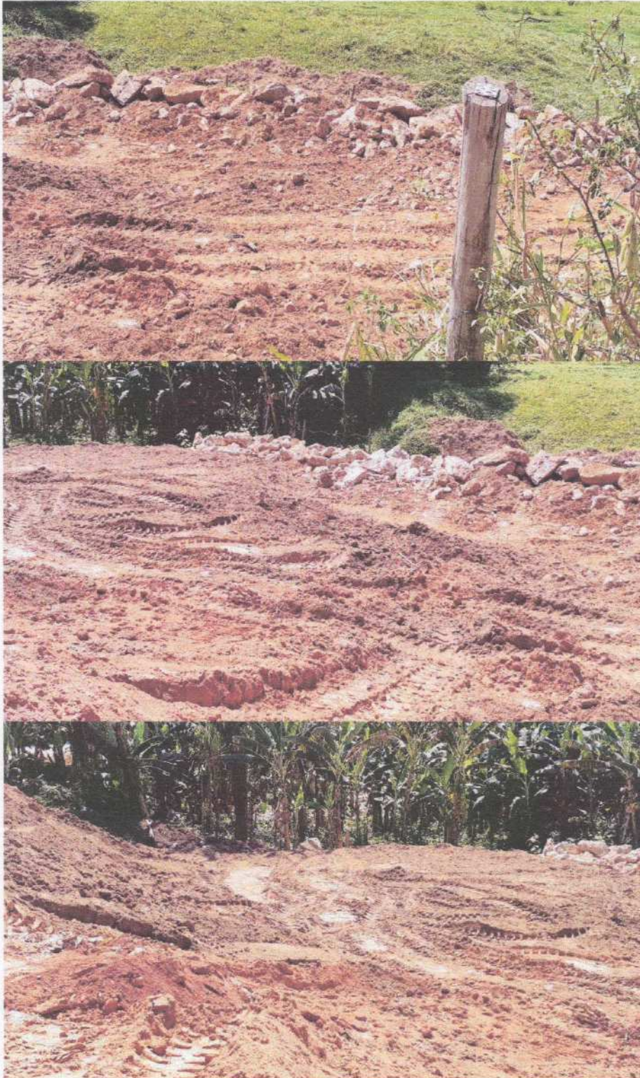
Imagens do terreno da Estação de Tratamento de esgoto
