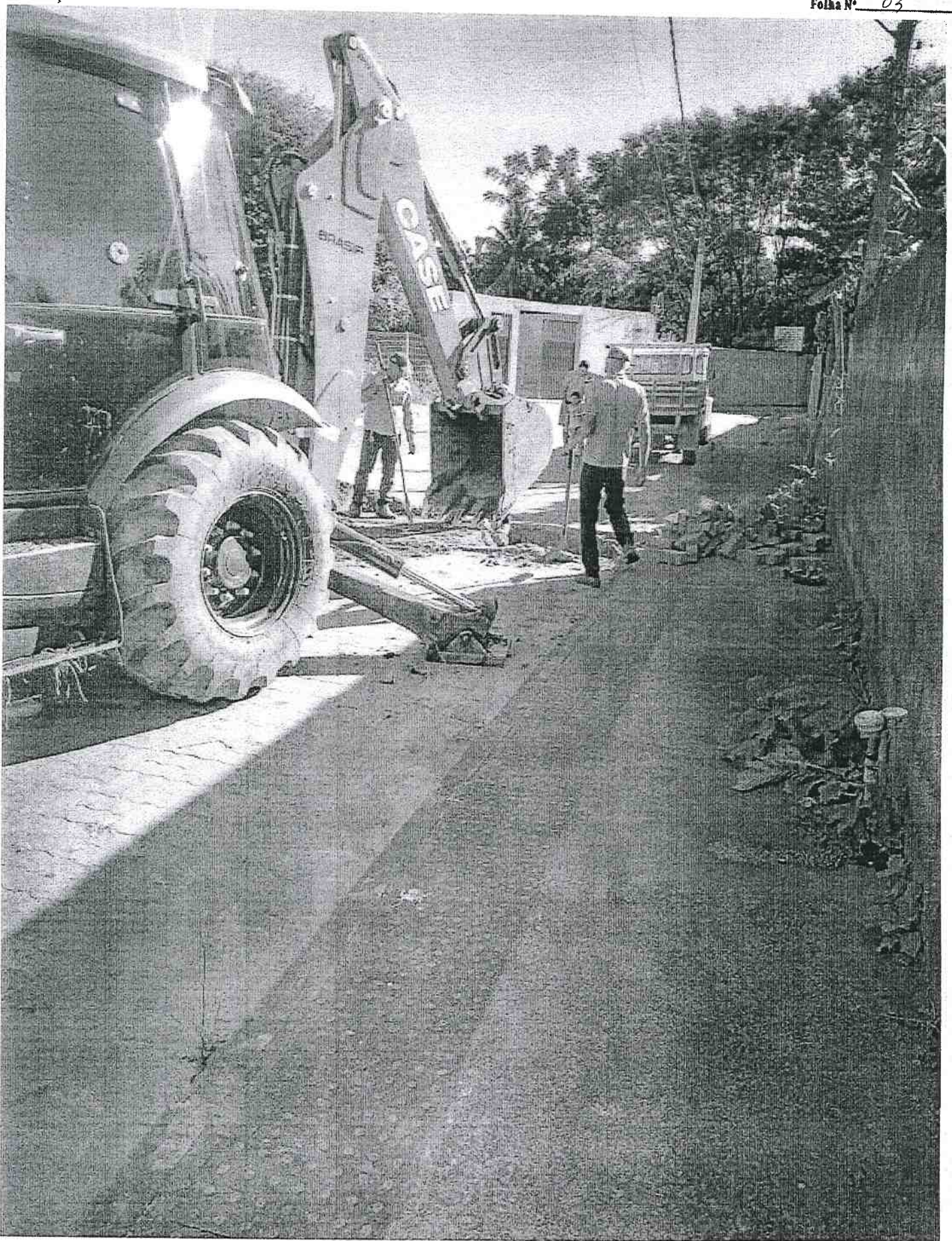
* Serviço de ligação de Rede de esgoto no Bairro caixa.
