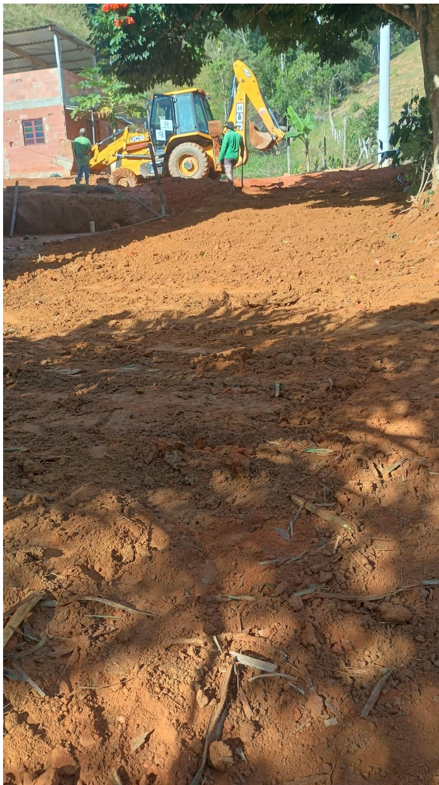
Fig. 05.. Adequação da saída das águas pluviais por meio da abertura e direcionamento do canal de drenagem, proporcionando melhor condução do fluxo hídrico.
