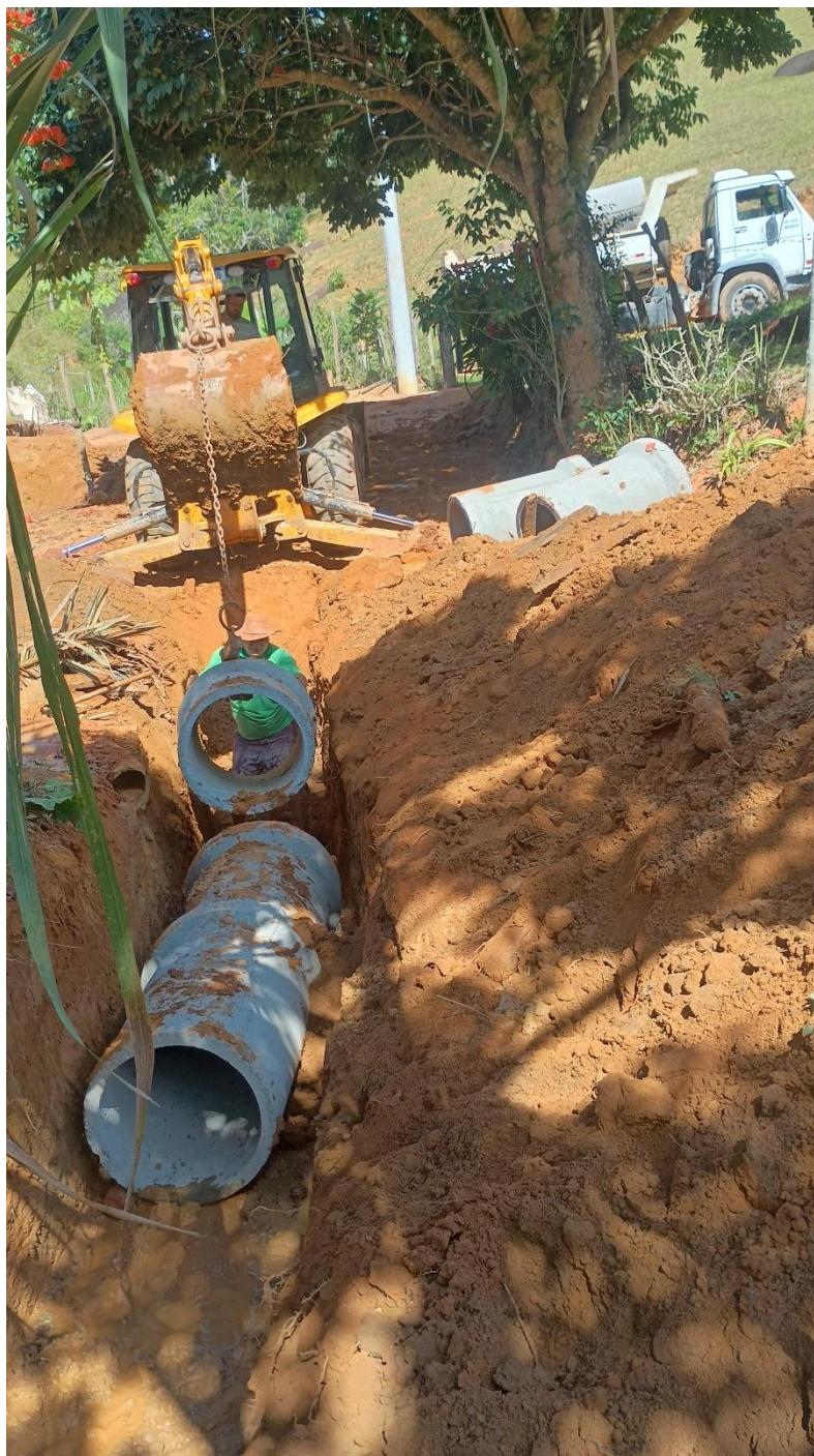
Fig. 03.. Realização dos serviços de escavação e conformação do trecho para instalação da estrutura de drenagem, conforme atendimento à Indicação nº 080/2026.
